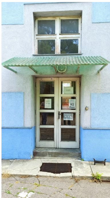
Obr.4 Pohľad na okná a dvere bočného schodišťa:
