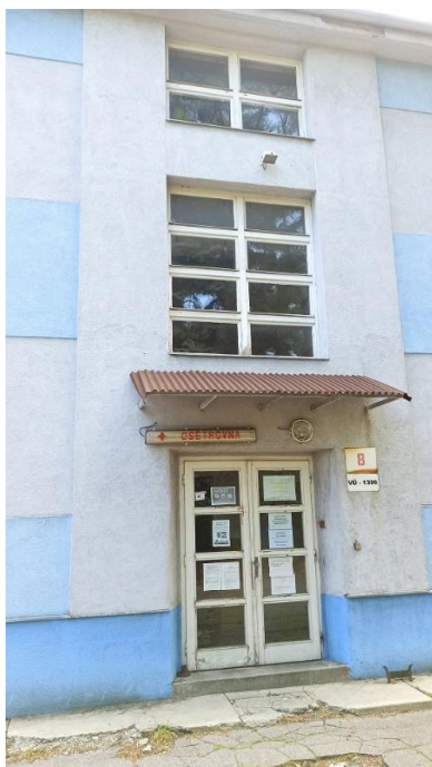
Obr.3 Pohľad na okná a dvere stredového schodišťa:
