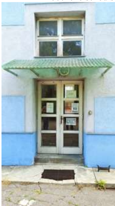
Obr.4 Pohľad na okná a dvere bočného schodišťa:
