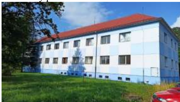
Celkový pohľad na budovu 8:
