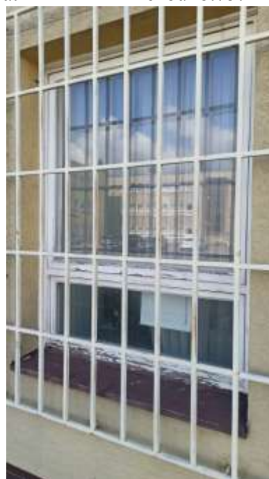
Obr.5 Detail okna z mrežou b.75:
