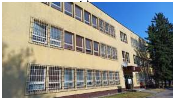
Celkový pohľad na budovu 75:
