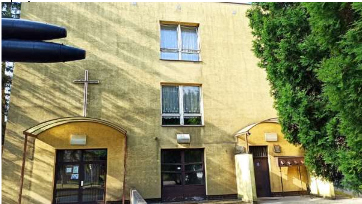
Obr.6 Detail bočných okien, dverí a vchodu do kaplnky
