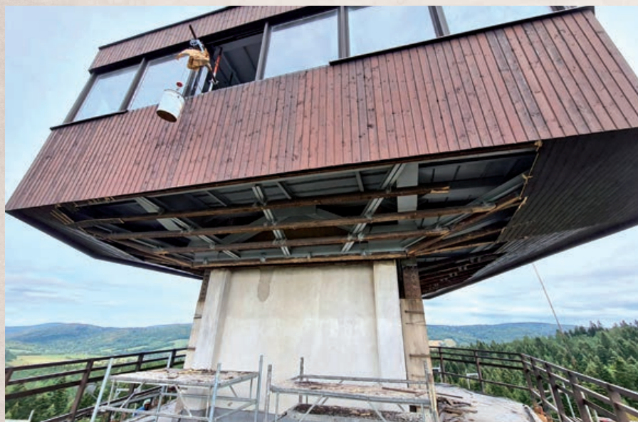
Rekonštruovaná vyhliadková veža na Dukle má nový plášť
