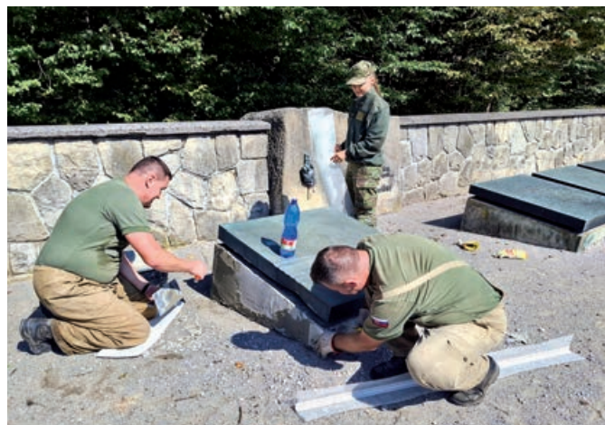
Oprava podstavcov pod tabuľami pamätníka na Dukle
