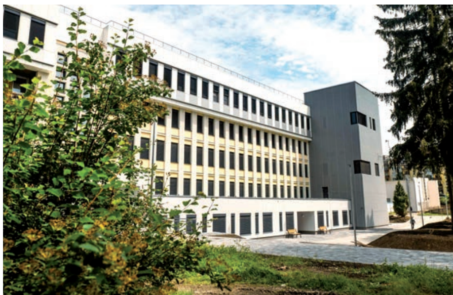
Východné krídlo chirurgického pavilónu
