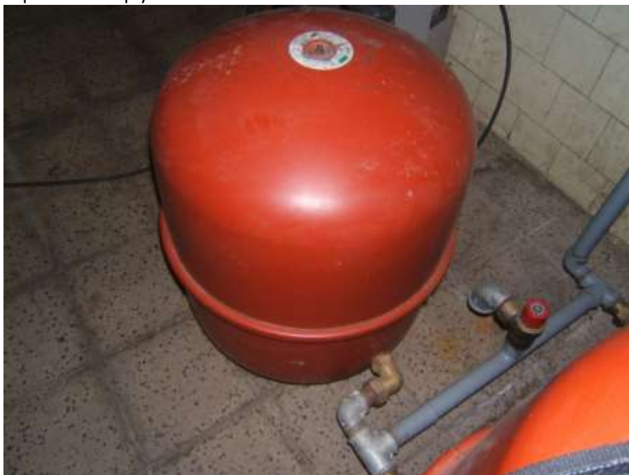
Expanzomat v plyn. kotolni Vlkanová
